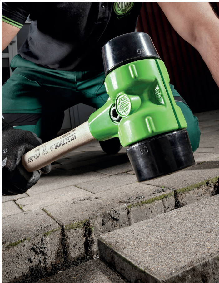
Einsatz eines Schonhammers Selecthor beim Verlegen von Pflastersteinen
